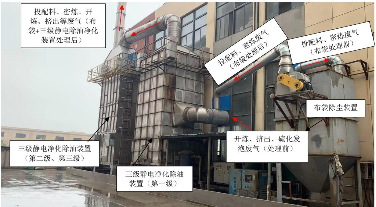
图4.1-3瑜伽垫投配料、密炼、开炼、挤出、硫化发泡废气处理设施
