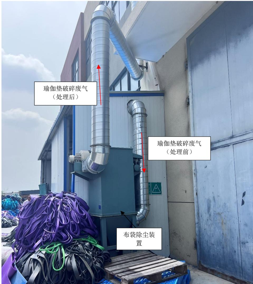
图4.1-4 瑜伽垫破碎废气处理设施
