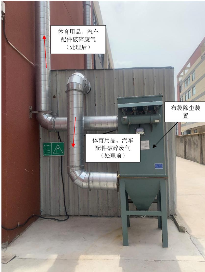
图4.1-6 体育用品、汽车配件破碎废气处理设施
