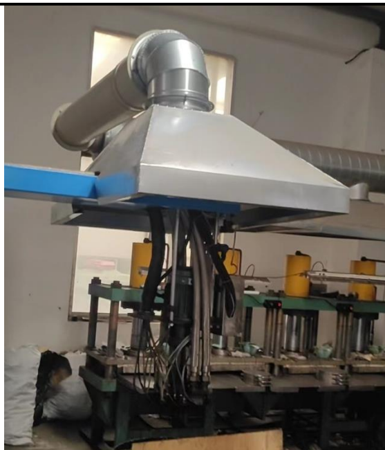
图 3-3 清洗废气收集管道照片
