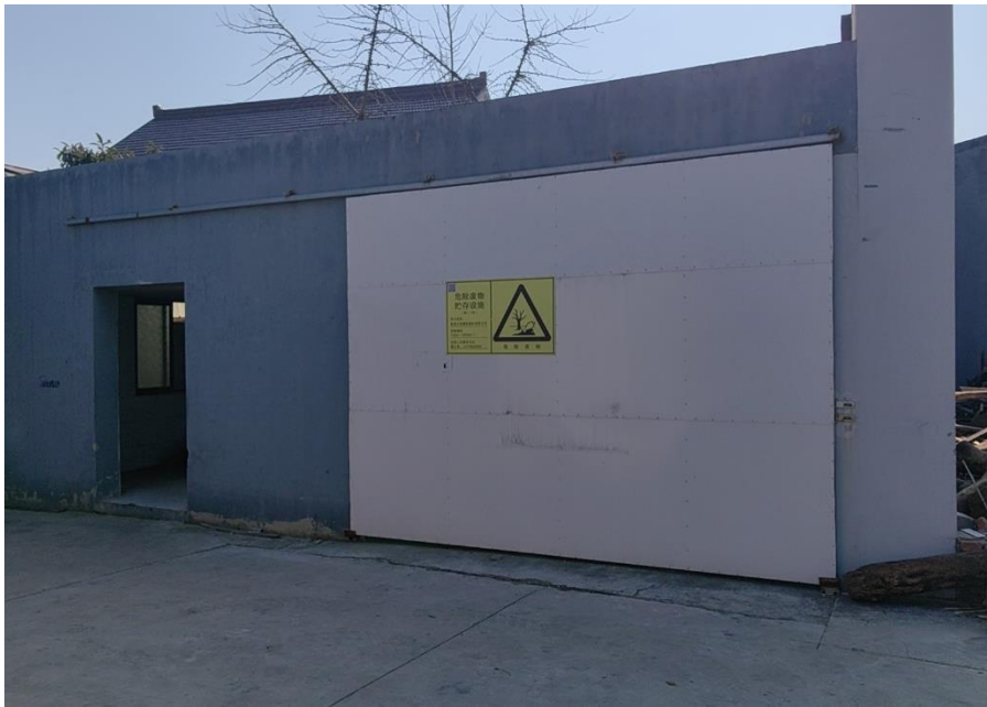
图 3-6 危废仓库外部照片
