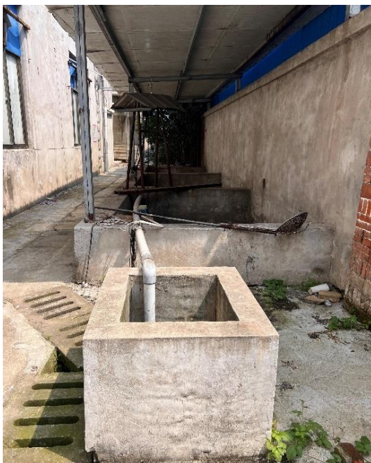
图 3-4 浆槽冲洗废水处理设施照片
