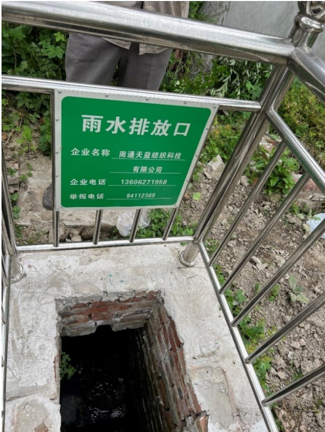
图 3-5 雨水排口照片
