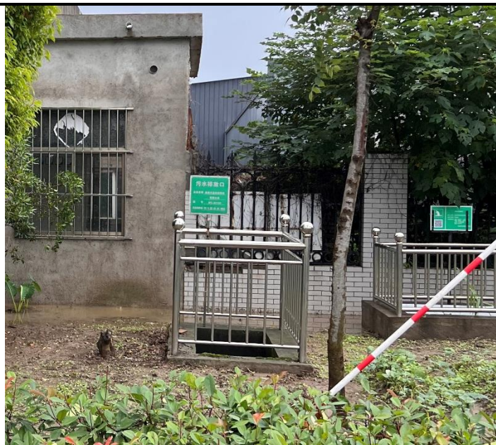
图 3-6 污水排口照片
