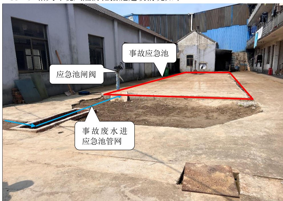
图 3-7 事故应急池照片
